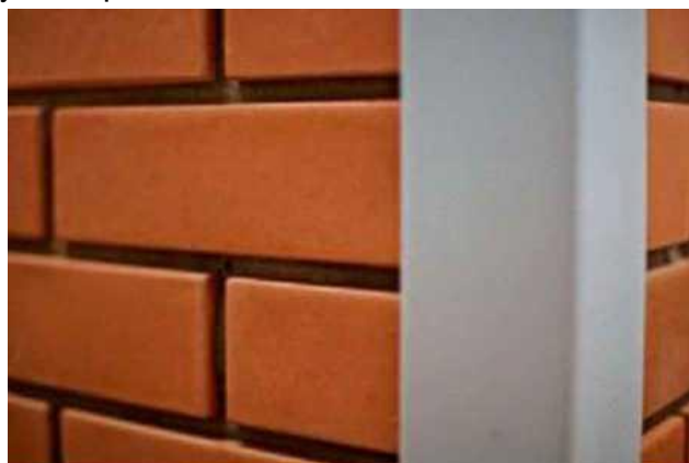
Стыковка внешнего угла с применением уголка
