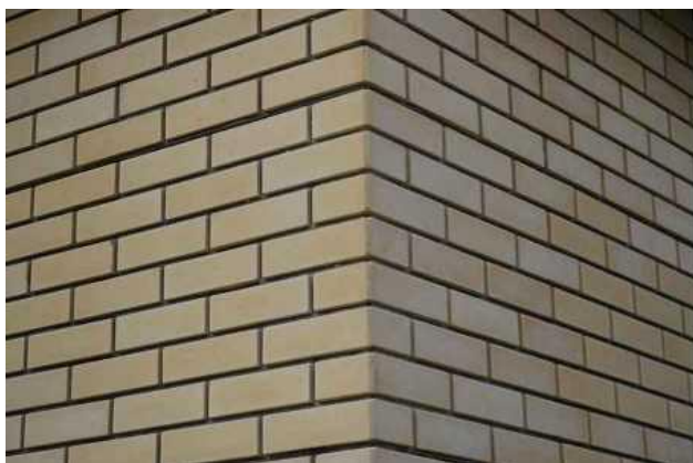
Стыковка внешнего угла с запилем панели под 45 градусов
